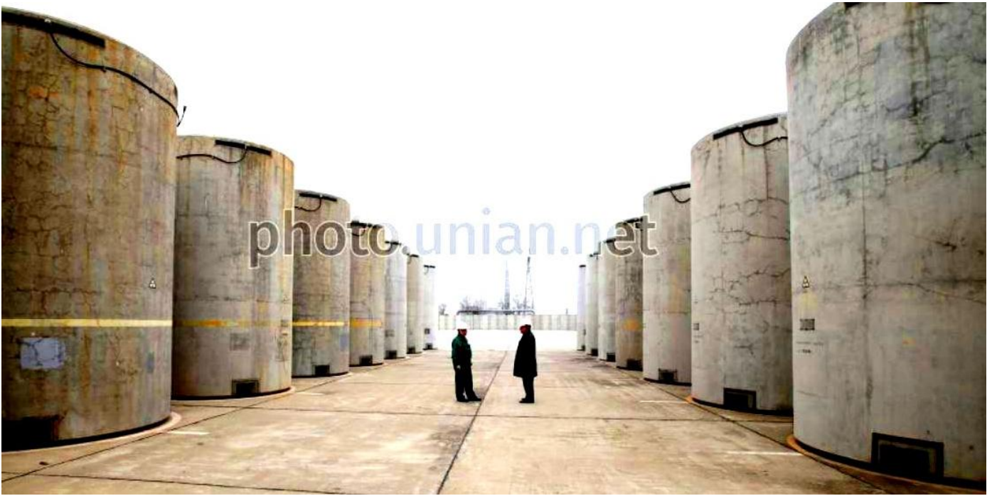
Ces 174 silos en béton contiennent quelques 4 200 assemblages au total.
